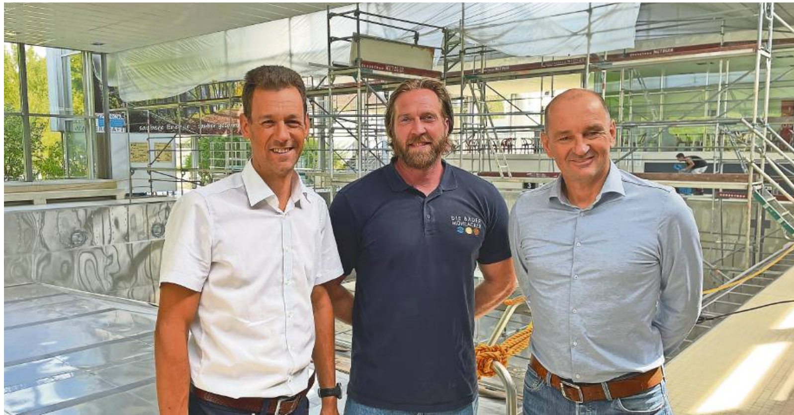
Roland Jans (von rechts), Geschäftsführer der Stadtwerke Mühlacker, Andreas Pfisterer, Betriebsleiter Bäder in Mühlacker, und Stadtwerke-Prokurist Frederik Trockel zeigen die aktuelle Baustelle im Hallenbad der Senderstadt. Hier werden gerade Maler- und Lackierarbeiten an der Fassade unterhalb der Decke durchgeführt. FOTOS: HEPPER
