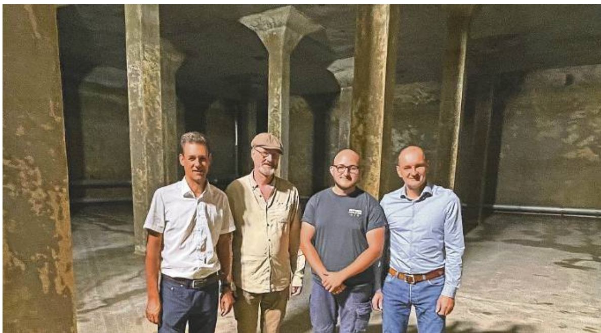
Wo im Hochbehälter Lindach normalerweise 2700 Kubikmeter Wasser gespeichert sind, herrscht derzeit gähnende Leere. Wie Achim Bruxmeier (Zweiter von links) und Marcel Kopf (rechts daneben) von den Stadtwerken erläutern, wird die Kammer gereinigt. Die Wasserversorgung der Stadt läuft gerade über die Anlage im Stöckach. Links: Frederik Trockel. Rechts: Roland Jans.
