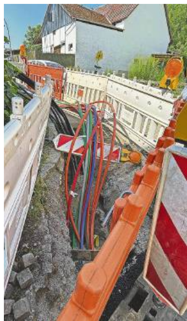
Der Glasfaserausbau mit Kabelverlegung, von den Stadtwerken beauftragt, macht in Mühlhausen Fortschritte.
