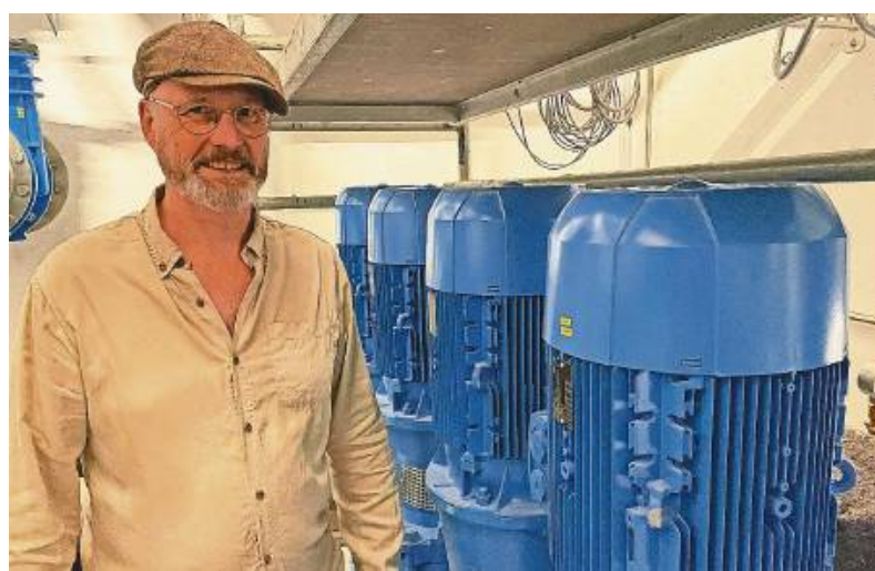
Das Herzstück der Mühlacker Wasserversorgung: Achim Bruxmeier präsentiert die vier Pumpen, die vom Hochbehälter Lindach aus das kostbare Nass verteilen.
