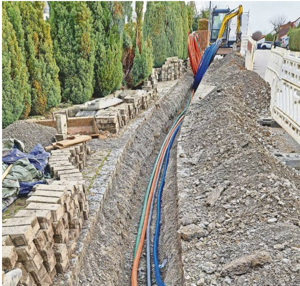
Die Glasfaser-Bauarbeiten in Mühlackers größtem Stadtteil Enzberg sind schon weit gediehen.
