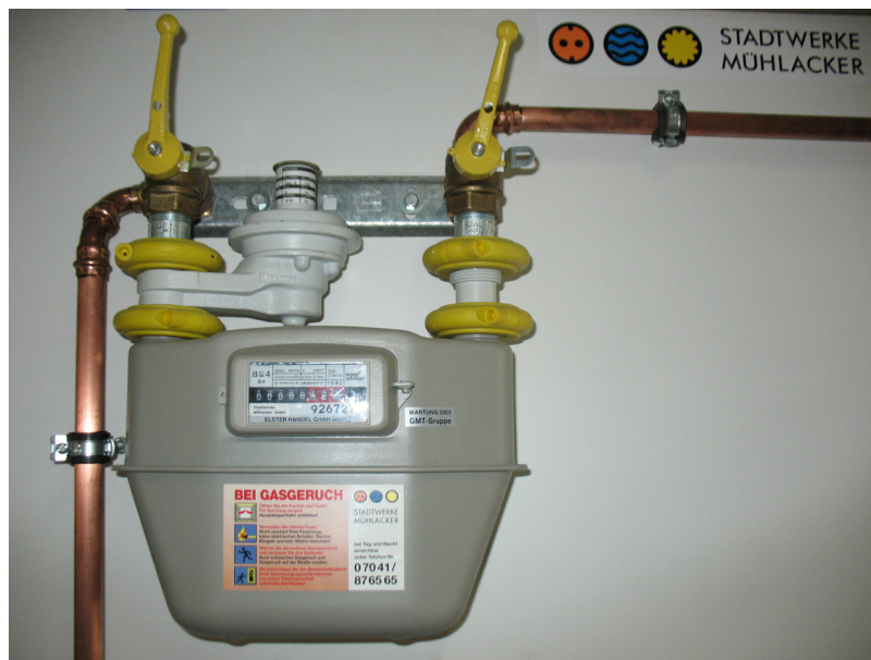
Abbildung 1 Zähleranschlussplatte mit Zweirohrbalgencähler
